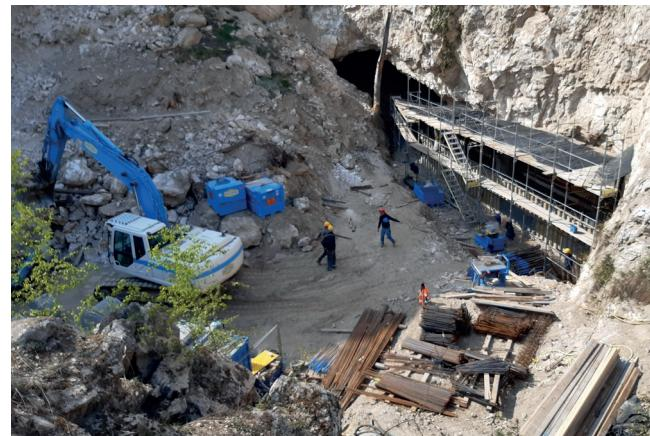
**Fig. 9:** L'ancienne carrière de gypse de Vaas: Construction de la galerie artificielle permettant de maintenir l'accès au réseau souterrain inférieur existant.
